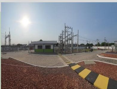
*Execução do remanejamento de 03 alimentadores da Subestação São José 69 kV com a instalação do 4º transformador de 69/13,8 kV para alívio de carga nas barras 01, 02 e 03*
