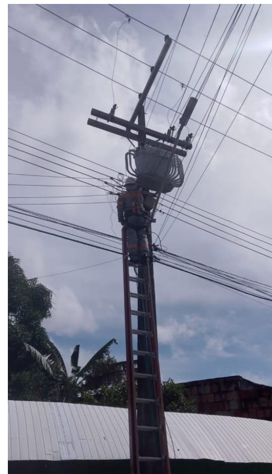
Imagens de manutenções corretivas ocorridas durante o ano de 2021. Fonte: Própria
