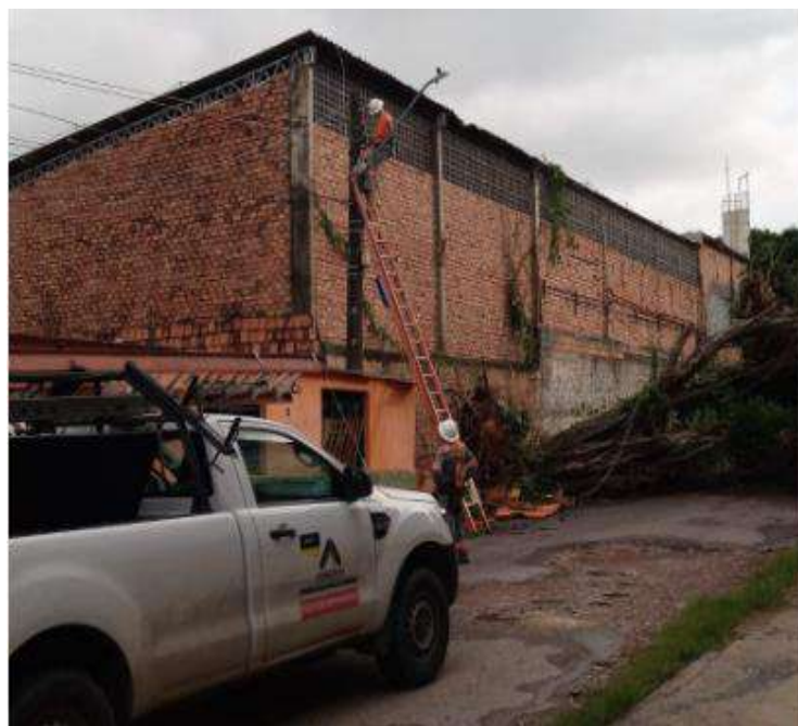
Figura 8. Vegetação caiu sobre a rede após a chuva – área residencial.
