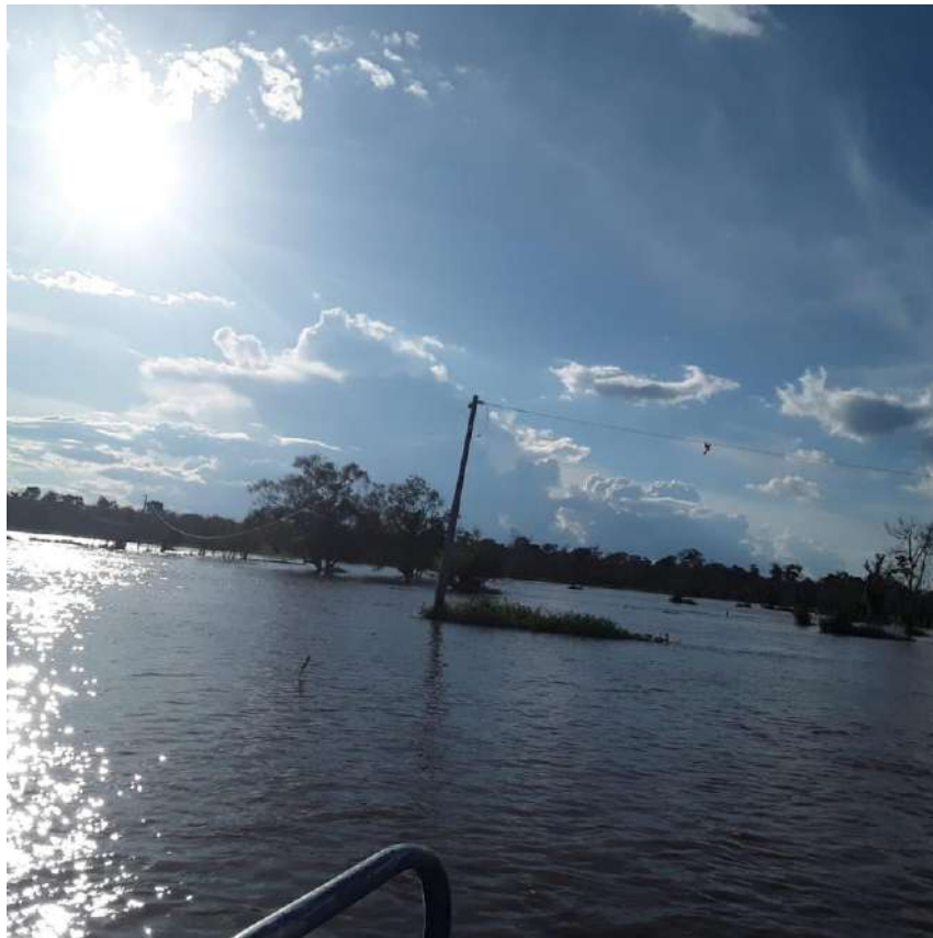
Figura 8. Cabo partido em região alagada.
