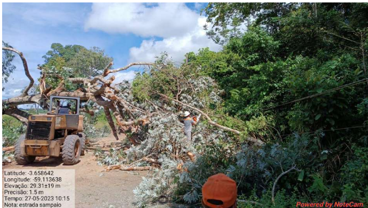
Figura 10. Equipe retirando árvore da rede de MT.
