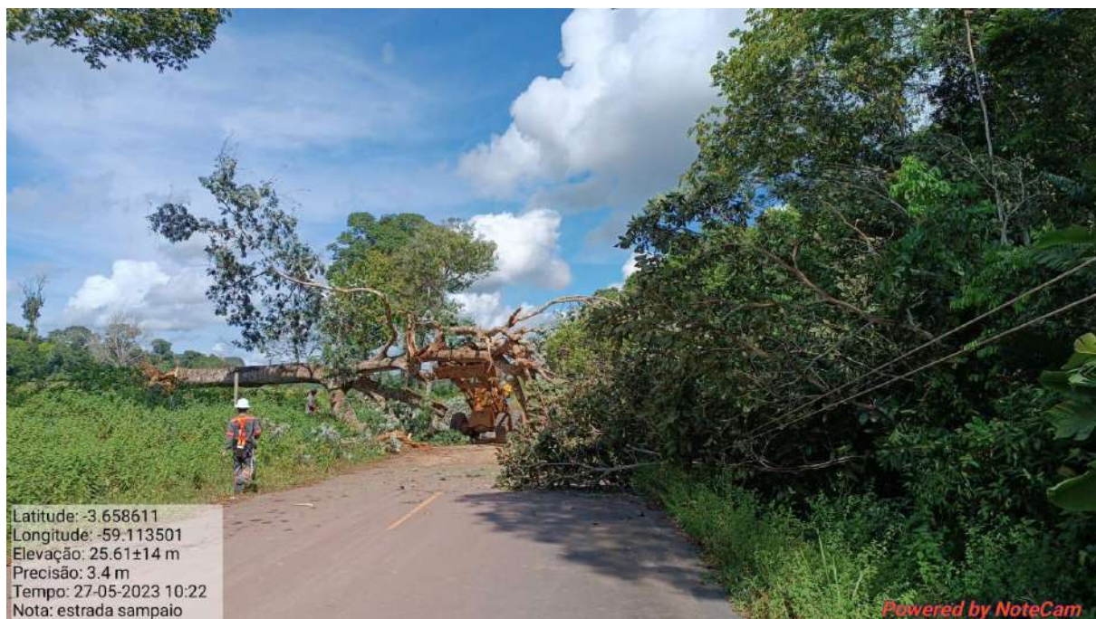
Figura 9. Equipe retirando árvore da rede de MT.
