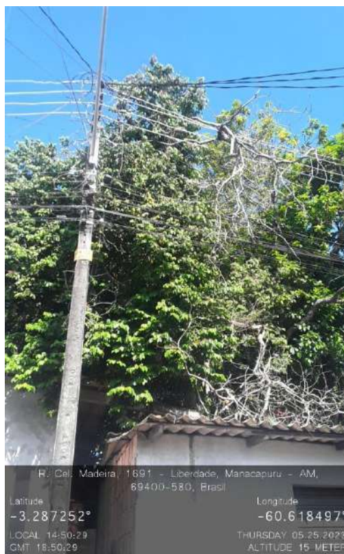
Figura 5. Árvore em propriedade particular sobre a rede de MT.
