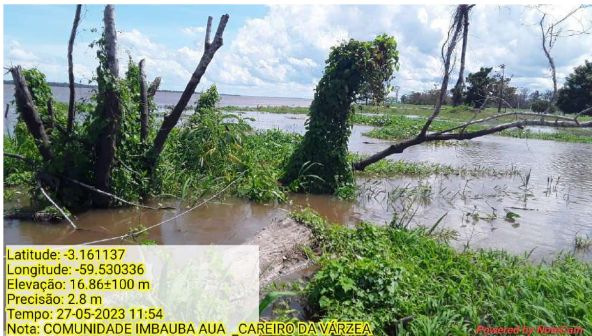
Figura 7. Cabo partido em região alagada.
