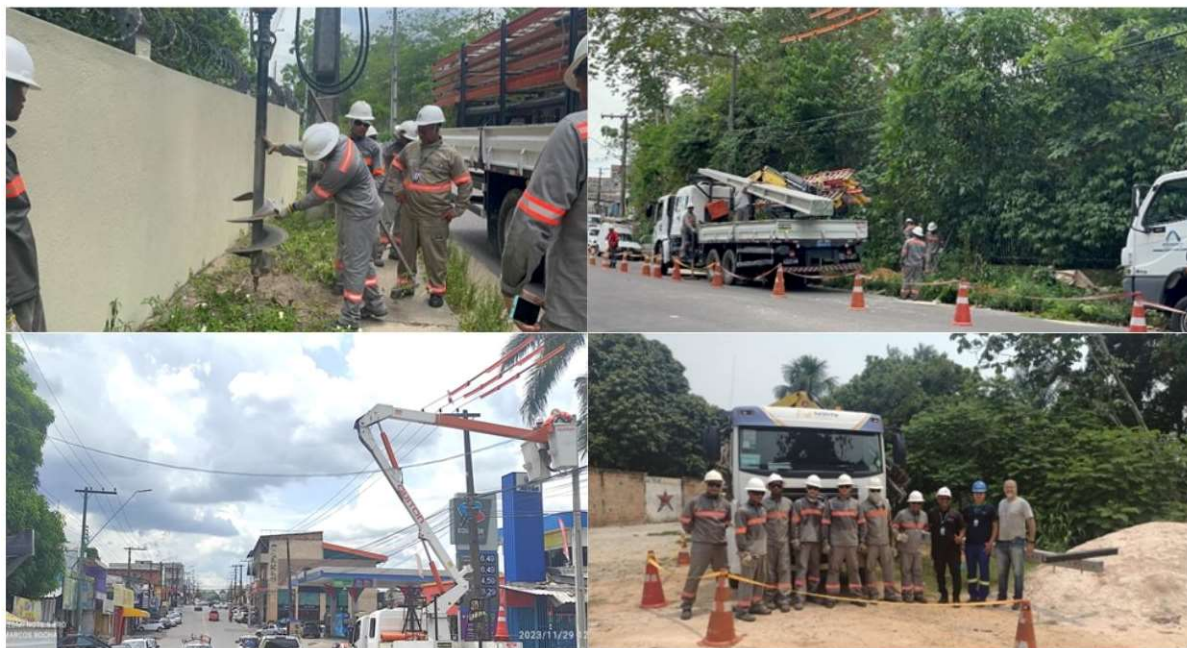
Figura 1. A – Equipe perfurando o solo para a implantação do poste; B- Equipe em implantação do poste; C – Equipe esticando a rede entre os dois postes; D- Registro final da execução do trabalho.
