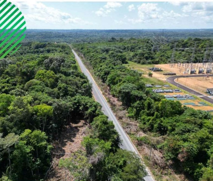
Usina Termoelétrica de Parintins
