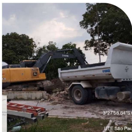
Retirada de resíduos contaminados
