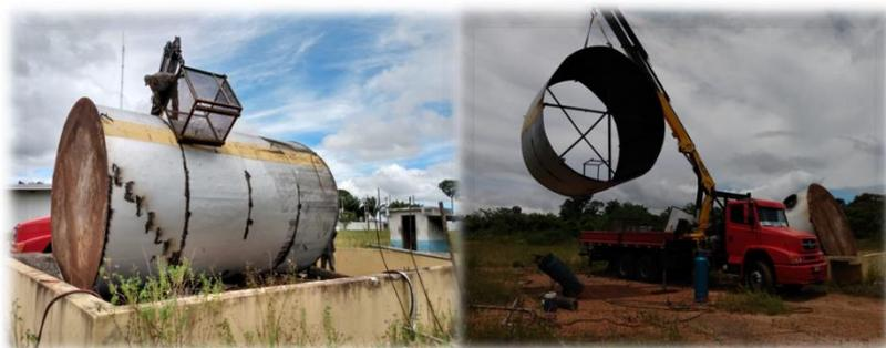
Figura 19: Desmobilização da Área da Tancagem da Usina
