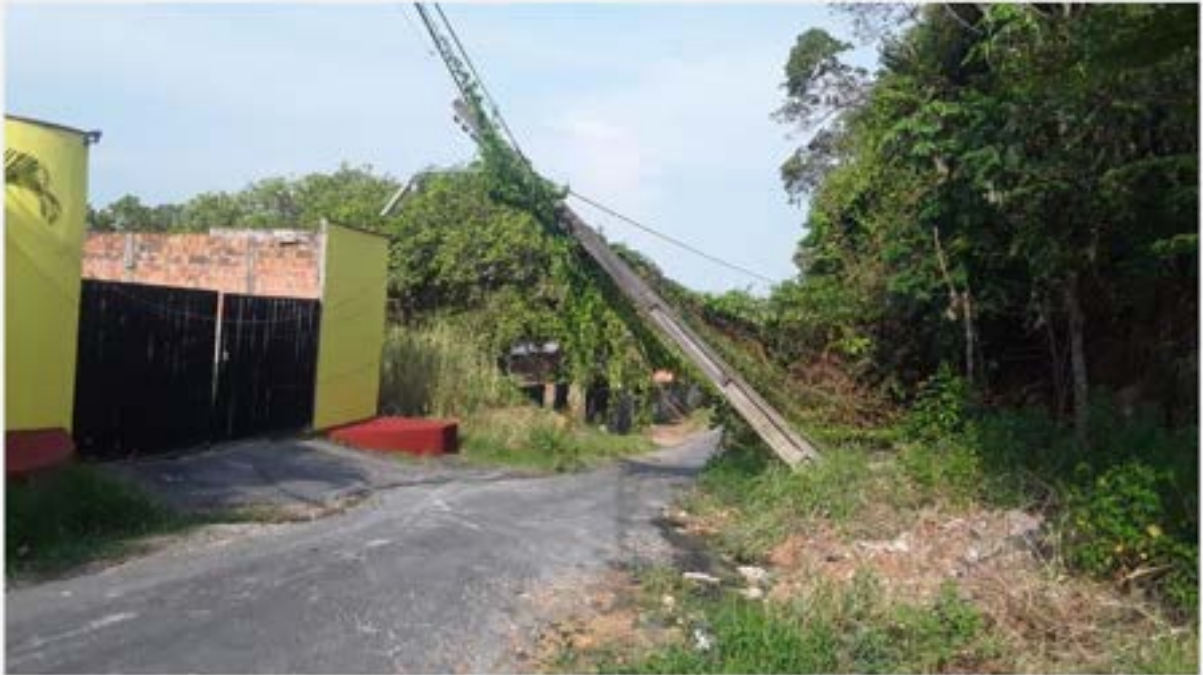
Fios ficaram danificados com a forte chuva (Foto: Divulgação/Amazonas Energia)
