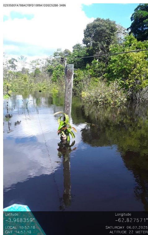
Figura 6. Atendimento em rede localizada em área inundada.
