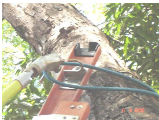
Foto 06 e 07 - Laçada do gancho da escada com o auxílio da vara de manobra
