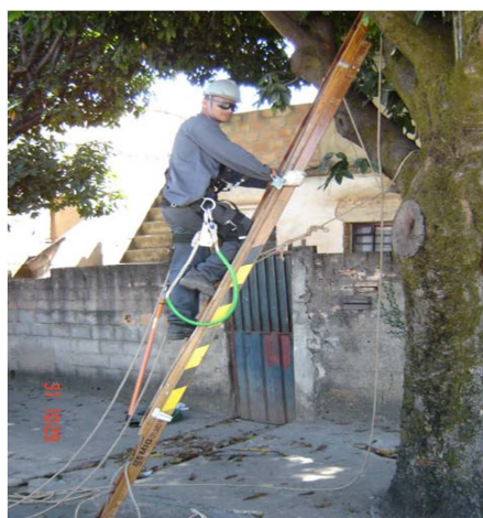
Foto 10 - posicionamento para a subida na escada Foto 11 - subida na escada utilizando a linha de vida
