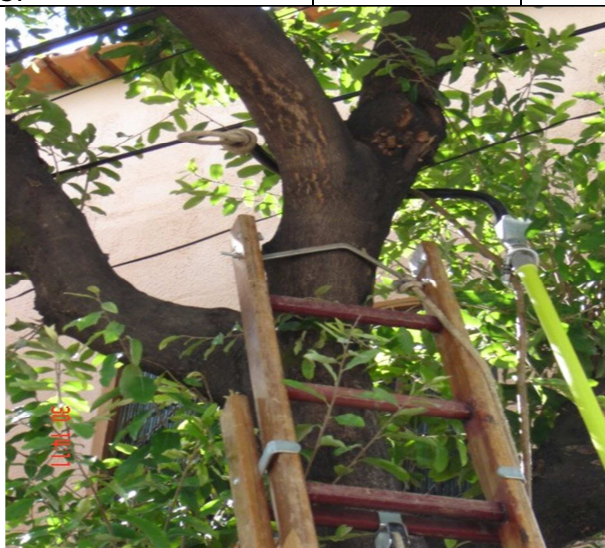
Foto 2 - Posicionamento da escada no tronco principal
