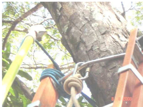
Foto 06 e 07 - Laçada do gancho da escada com o auxílio da vara de manobra
