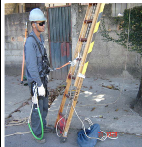
Foto 10 - posicionamento para a subida na escada Foto 11 - subida na escada utilizando a linha de vida
