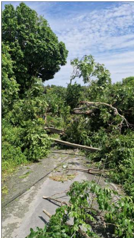
Figura 8. Poste caído e vegetação sobre a rede.
