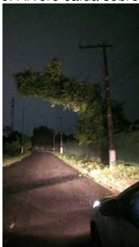
Figura 6. Árvore caída sobre a rede.
