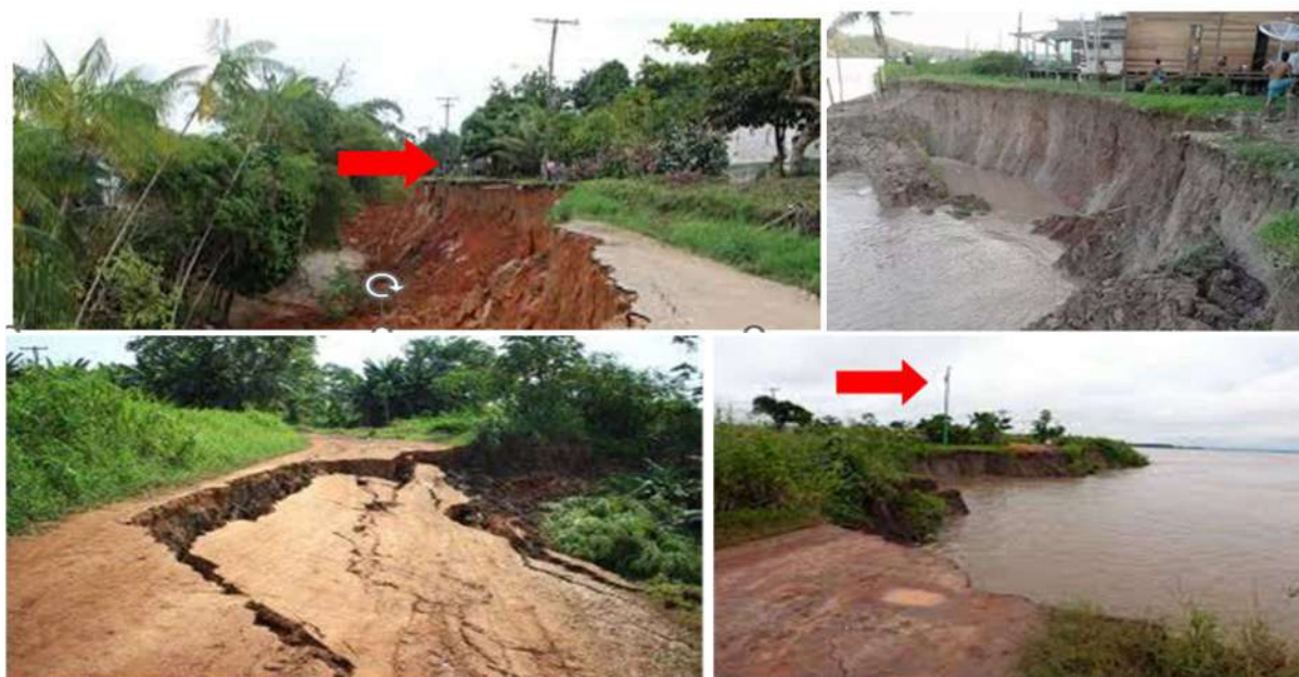
Figura 7 – Fenômeno terras caídas.
